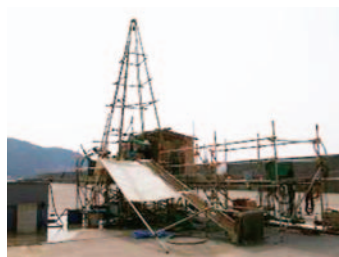
陸地ボーリング調査の様子
